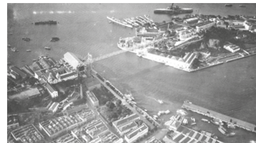
O Arsenal de Marinha e a Ilha das Cobras. Vê-se a ponte Alexandrino de Alencar que ligava o continente à Ilha das Cobras. Junto à ponte a Carreira Almirante Tamandaré. À direita, o atual Espaço Cultural da Marinha. Foto feita pela Aviação Naval entre 1916 e 1923.
